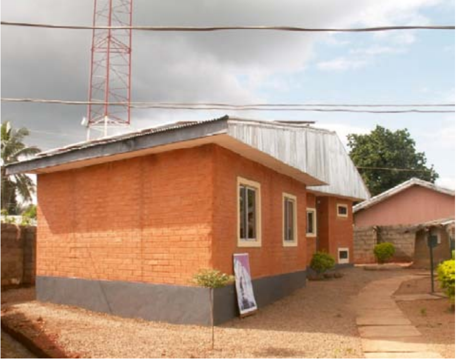
شكل 11.2: قام الشبان في بلدة كافانتشان ببناء مركز إدارة الشبكة باستخدام الطوب المصنع محلياً.
