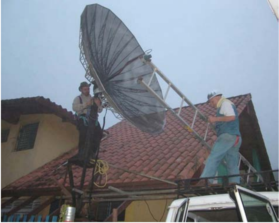
شكل 11.30: كارلو وإرمانو أثناء تفكيك طبق الاستقبال الفضائي الذي قدمه السيد إسماعيل سانتوس.
