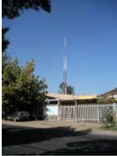
شكل 11.21: نقطة في شمال سانتياغو تتألف من برج بارتفاع 15 متراً وهوائي من طراز Trevor Marshall 16+16 و30 زبوناً. تتصل هذه النقطة بنقطة أخرى في وسط المدينة على بعد 12 كيلومتر.
