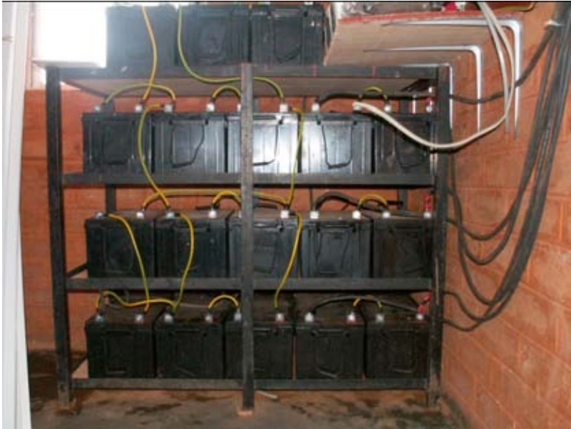
شكل 7.9: مجموعة بطاريات استطاعتها 3600 أمبير ساعي، تصل شدة التيار أثناء الشحن إلى 45 أمبير.
